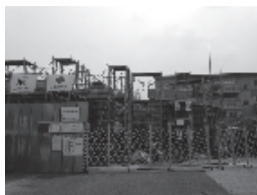
長谷場新宿寮建築工事の様子
